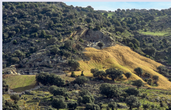
Fig. 7. Arriba: cantera con anterioridad a la restauración. Abajo: aspecto tras el remodelado topográfico, extendido de suelos y revegetación
