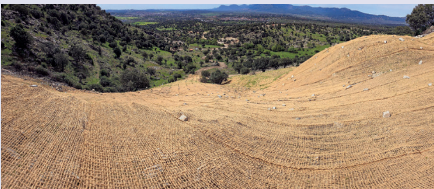
Fig. 11. Izquierda: red de fibra de coco instalada en cantera restaurada. Derecha: siembra manual tras el remodelado geomorfológico
