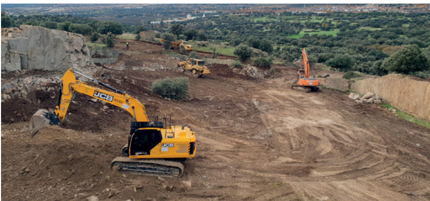
Fig. 3. Maquinaria trabajando en la restauración de las canteras de granito de Alpedrete: buldócer D6, dos retroexcavadoras y camión articulado
