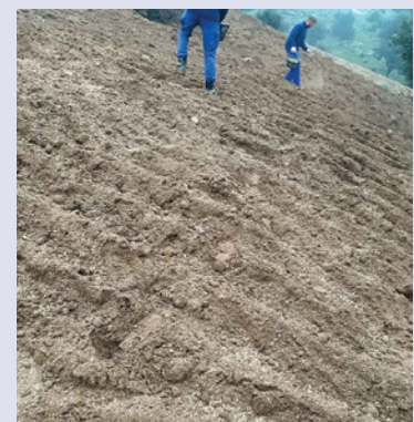
Fig. 11. Izquierda: red de fibra de coco instalada en cantera restaurada. Derecha: siembra manual tras el remodelado geomorfológico
