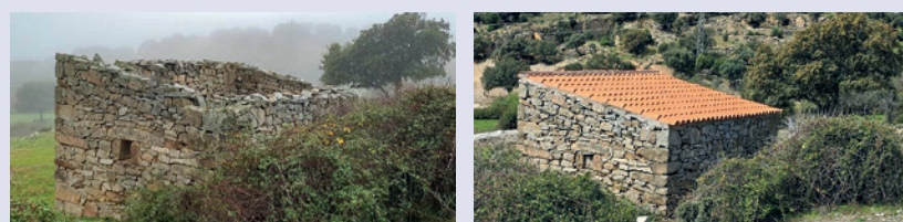
Fig. 15. Arriba, izqda.: detalle del diseño para la recuperación de la cubierta de una choza. Arriba, dcha.: murciélago grande de herradura ( Rhinolophus ferrumequinum ) en el interior de una cueva en una cantera cercana. Abajo, aspecto de la edificación antes y después de su rehabilitación"
