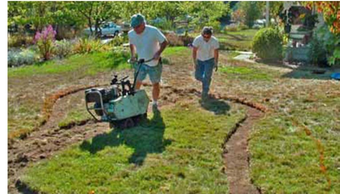
Eliminación de la cubierta de césped antes de la excavación
