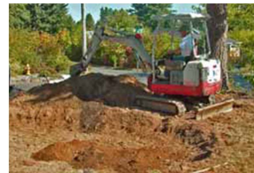
Uso de una pequeña excavadora para los jardines de lluvia de mayor tamaño
