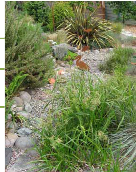
Plantas y rocas protegen de la erosión este cauce de drenaje de agua
