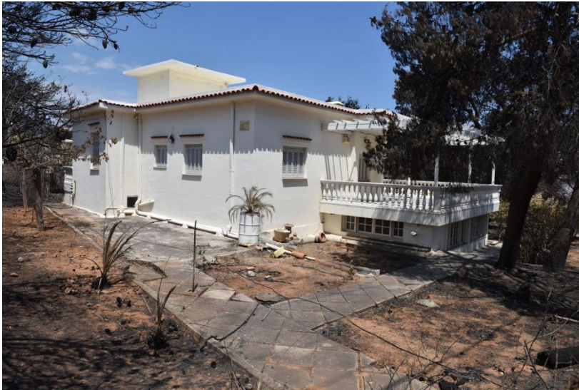
1. Sin daños apreciables
