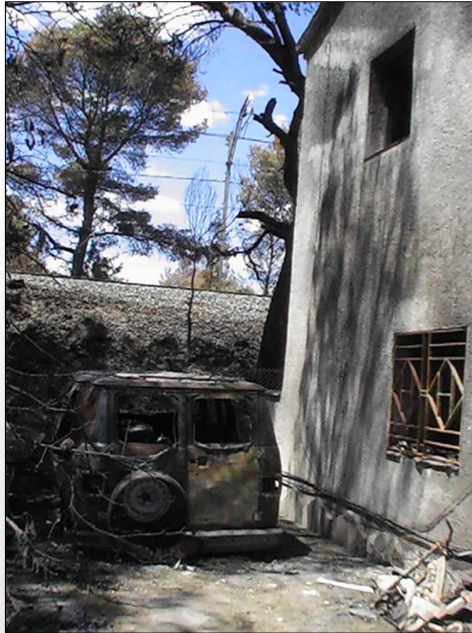
Incendio Mont-Roig, verano 2007
