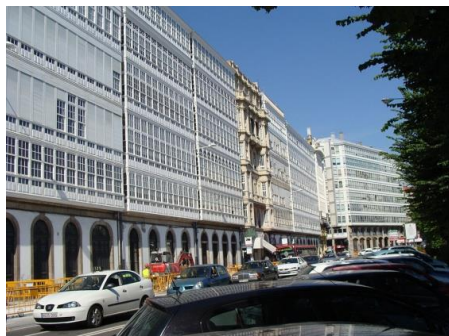
Ventanas orientadas al sur (A Coruña)
