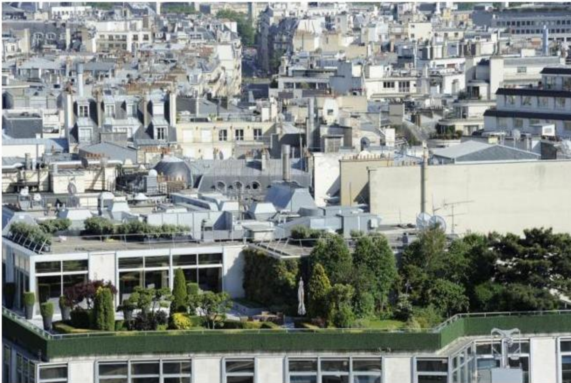
Un 'techo verde' en un tejado de un edificio de Francia. | FRANK DUNOUAU
