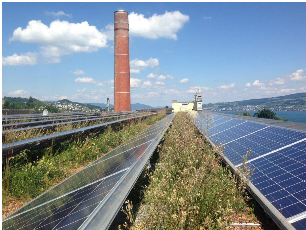
Techo verde biosolar Suiza
