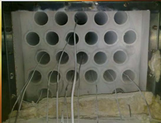
**Instalación de sondas de temperatura en tubuladores de pasos de humo**
